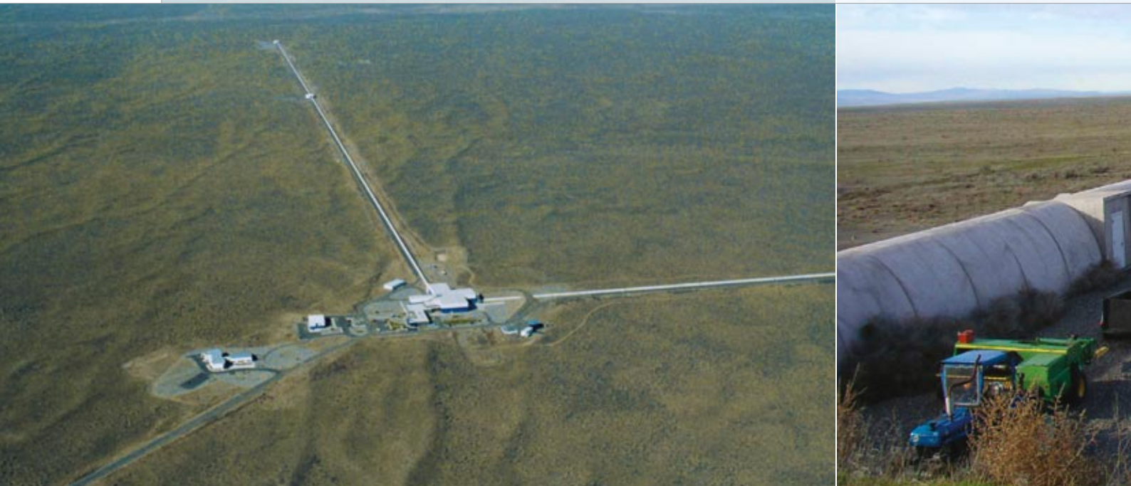
Am Laser-Interferometer LIGO (hier die Station in Hanford, Washington, USA) sollen zum ersten Mal Gravitationswellen gemessen werden. Jeder der beiden Interferometerarme hat eine Länge von 4 km. Bilder mit freundlicher Genehmigung des LIGO-Projekts.
