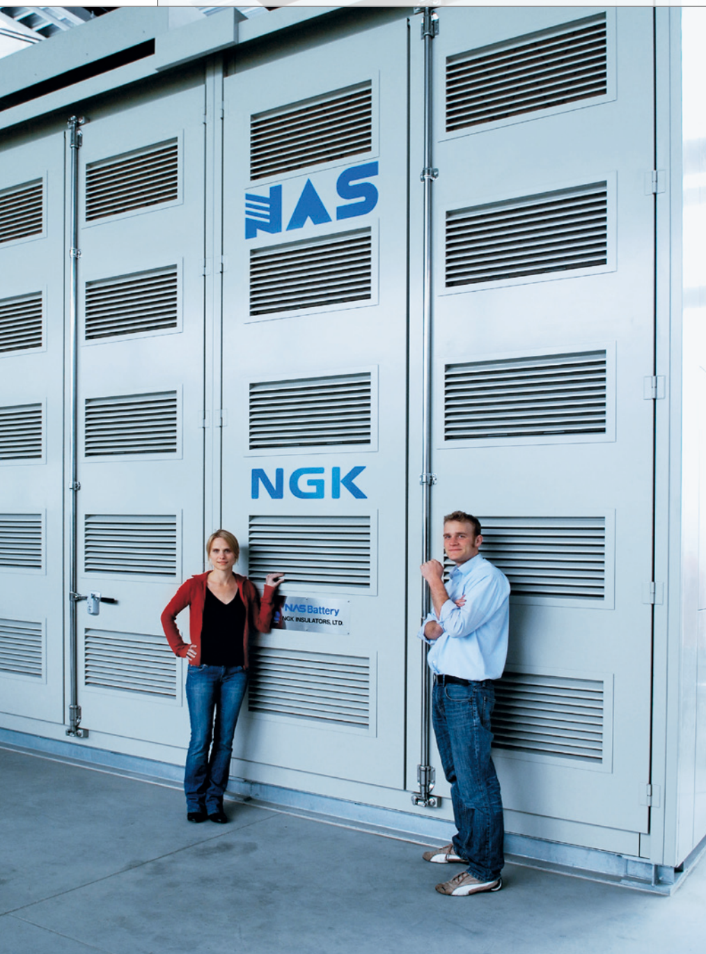
図3：ナトリウム硫黄電池が電力変動を安定化させ、「電力不足」の時期に備えたエネルギー貯蔵器の役割を果たします。
