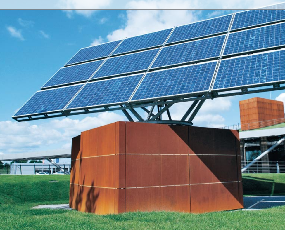
Abbildung 4: Ein weiteres Younicos-Projekt nutzt ebenfalls die Kraft der Sonne: Diese Solaranlage speist eine autarke Tankstelle für Elektrofahrzeuge.
