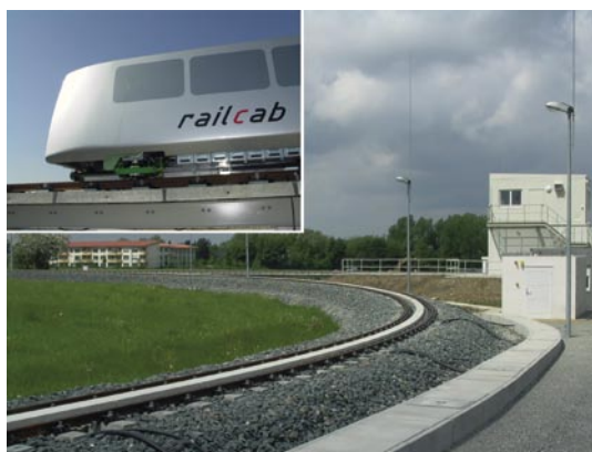
▲ Die RailCab-Teststrecke mit herkömmlichen geschotterten Schwellen an der Universität Paderborn: Testen unter realen Bedingungen.
