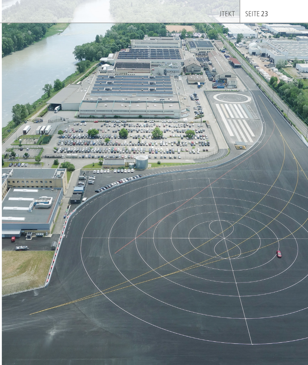
Prüfzentrum von JTEKT Europe in Irigny: Die hier durchgeführten Fahrversuche mit neuen Lenksystemen werden durch den HIL-Prüfstand perfekt ergänzt. Weil viele Unstimmigkeiten der Lenkungsregelung bereits am Simulator beseitigt werden können, erhöht sich auch die Sicherheit der hier arbeitenden Testfahrer.
