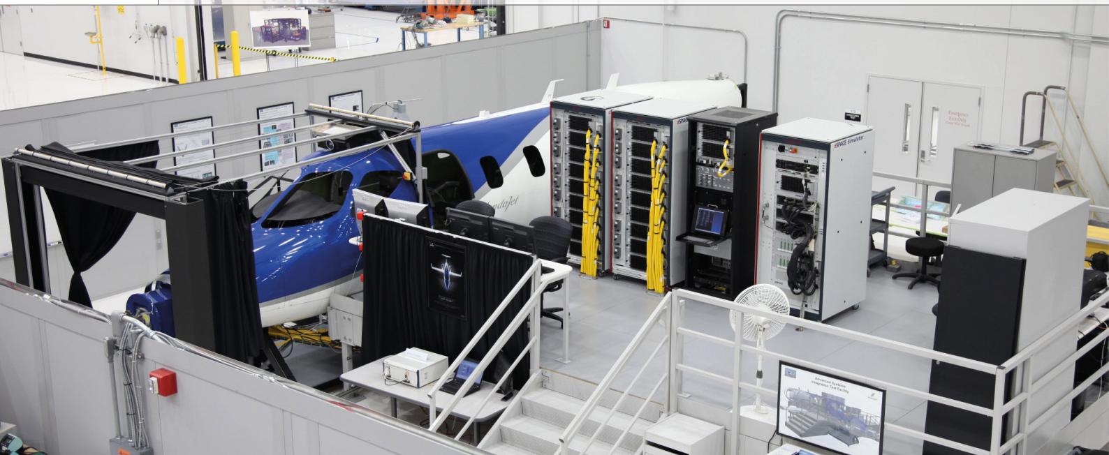
Der Testaufbau bestehend aus dem Iron Bird (links) und den drei dSPACE HIL-Simulatoren (Mitte).
