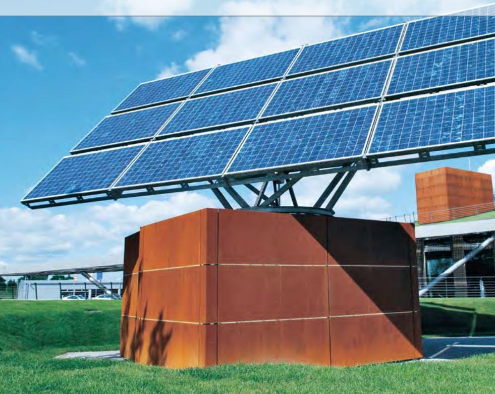
Abbildung 4: Ein weiteres Younicos-Projekt nutzt ebenfalls die Kraft der Sonne: Diese Solaranlage speist eine autarke Tankstelle für Elektrofahrzeuge.
