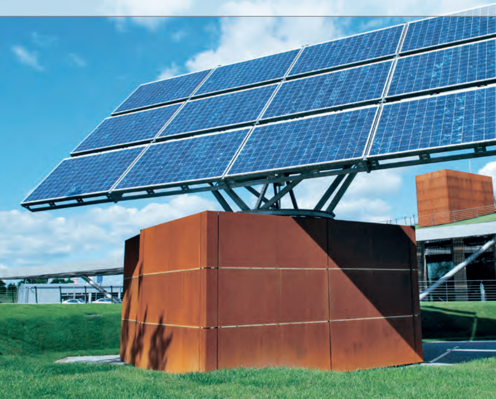
図4：Younicos 社の別のプロジェクトでは太陽エネルギーも使用しています。このソーラーパワーシステムから、電気自動車用の自律型充電ステーションに電力を供給します。
